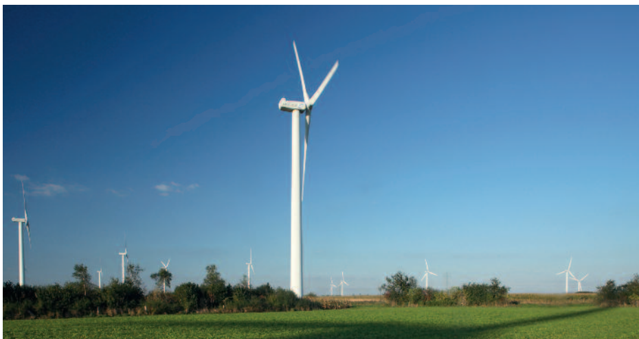
Der Windpark Krempel II liegt zwischen Bremerhaven und Cuxhaven, in attraktiver Küstennähe. Fünf Anlagen vom Typ Nordex N-60/1.300kW speisen hier seit mehreren Jahren Strom ins Netz
