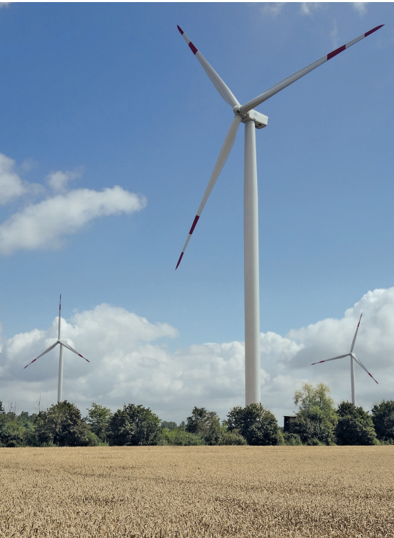
Drei Anlagen vom Typ GE 2,85-103 erzeugen im Windpark Hürth umweltfreundlich Strom.
